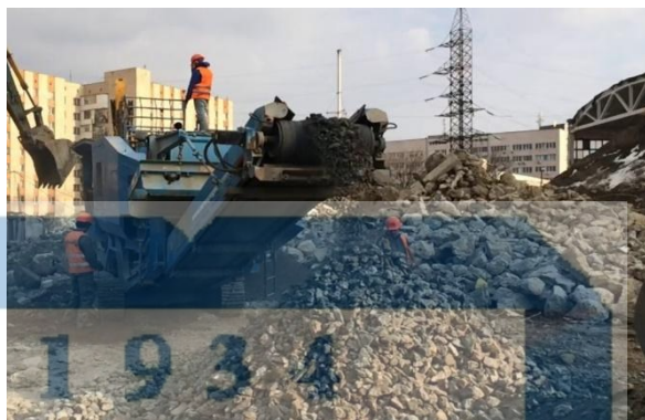
Сурет 1 - Бетонды ұсақтау процесі
